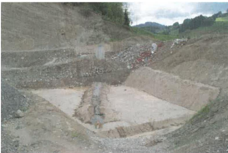
Abbildung 9: Basisabdichtung, Entwässerung
