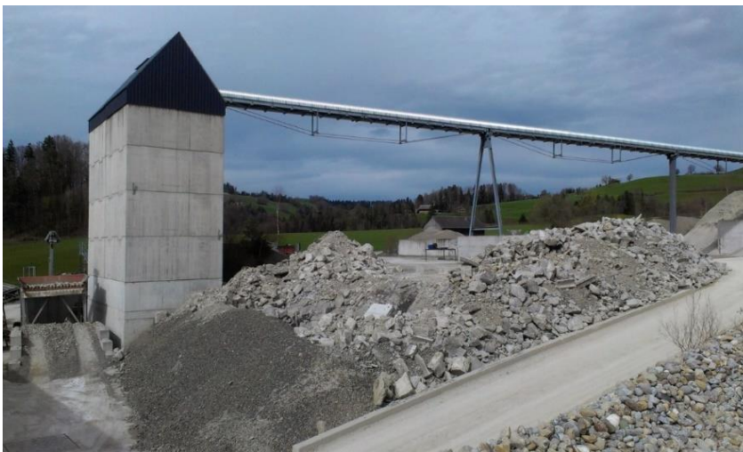
Abbildung 6: Förderband mit Zwischensilo
